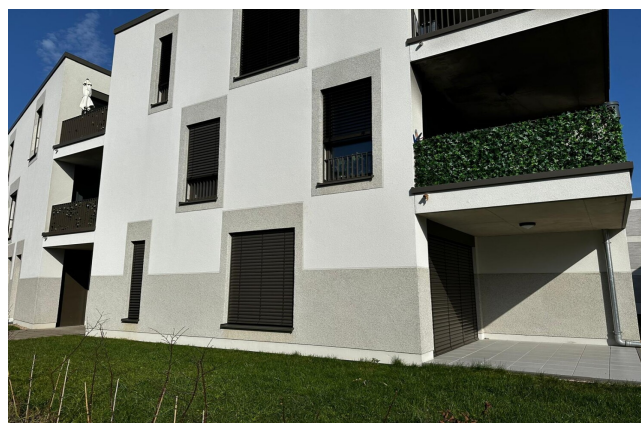
Façade de la résidence SALVIA
