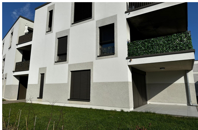
Façade de la résidence SALVIA
