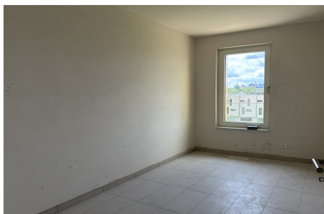
chambre de l'appartement 042 à Esch-sur-Alzette
