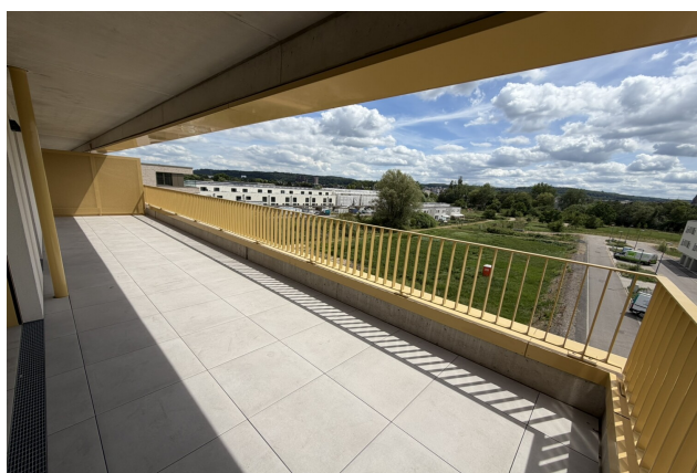
terrasse de l'appartement 042 à Esch-sur-Alzette
