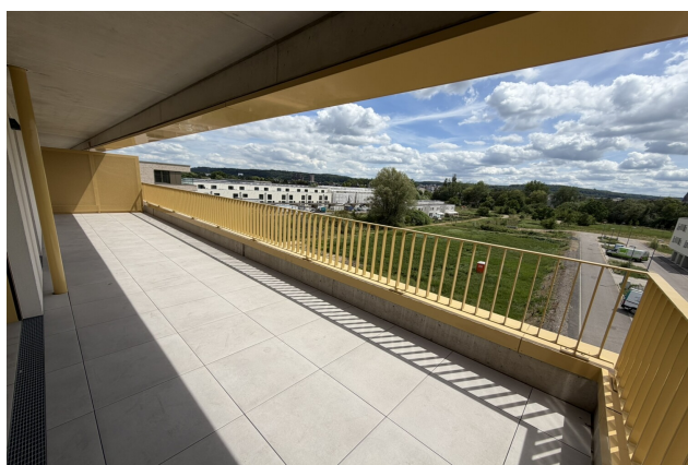
terrasse de l'appartement 042 à Esch-sur-Alzette
