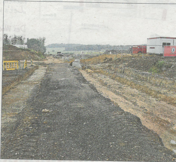
Die Erdarbeiten laufen auf vollen Touren.
