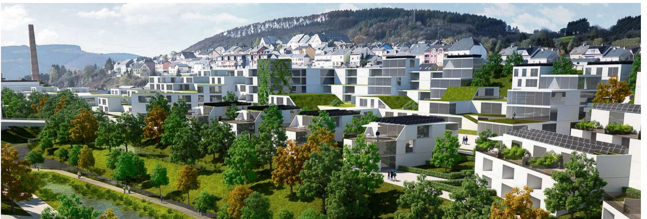
Le grand projet immobilier de Wiltz viendra s'implanter en lieu et place d'anciennes friches industrielles
