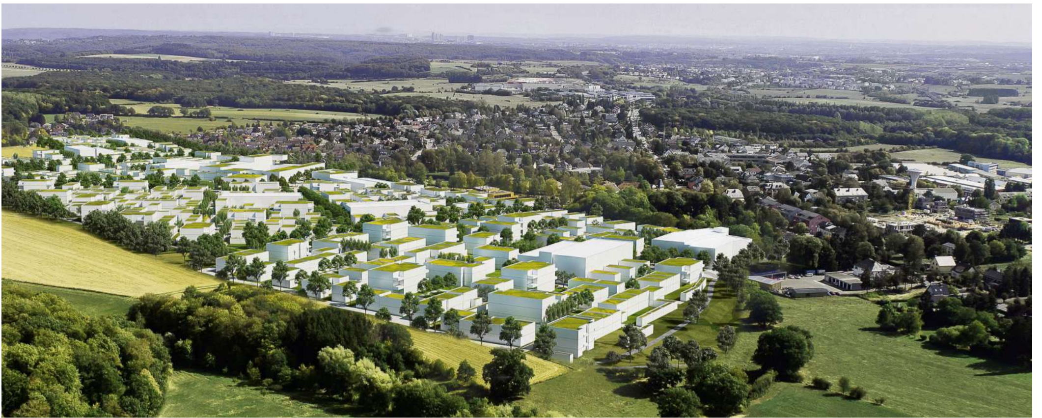
A Olm, les trois unités villageoises sortiront progressivement de terre. Elles ont vingt ans pour grandir et accueillir 2.000 nouveaux habitants
