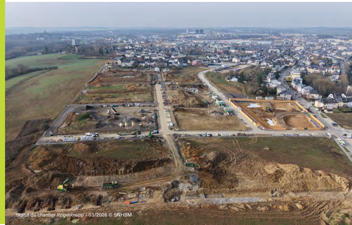
Les premières résidences ont été mises en chantier en septembre 2025.
